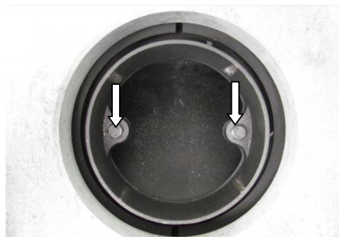
Fig. 6 : vis de manchon du tuyau de fumée
