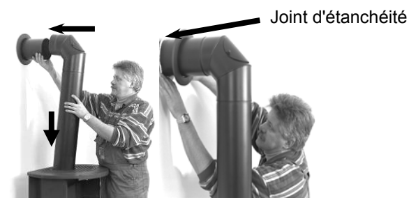
Fig. 5 : montage du tuyau de fumée
