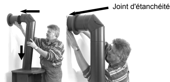
Fig. 5 : montage du tuyau de fumée
