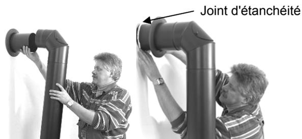
**Fig. 17 : raccordement du tuyau de fumée à la cheminée**
