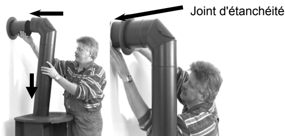
Fig. 5 : montage du tuyau de fumée
