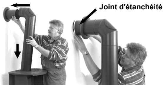
Fig. 7 : montage du tuyau de fumée
