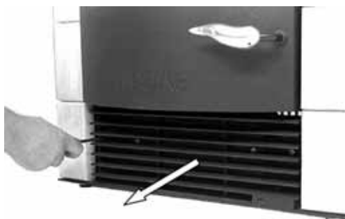
Fig. 113 : démontage de la grille de ventilation
