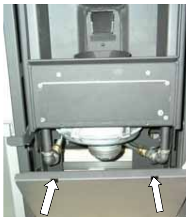
Fig. 144 : démontage du tablier d'habillage
