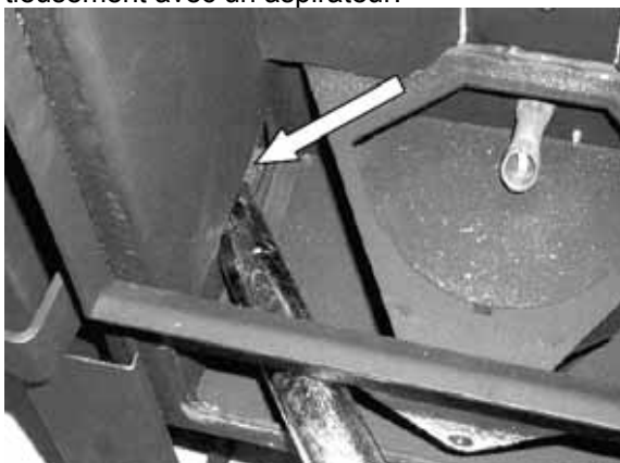
Fig. 128 : nettoyage des tirages de gaz de combustion inférieurs
