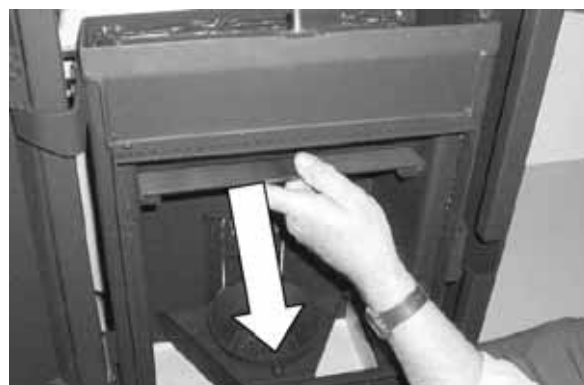
Fig. 150 : retrait du déflecteur inférieur
