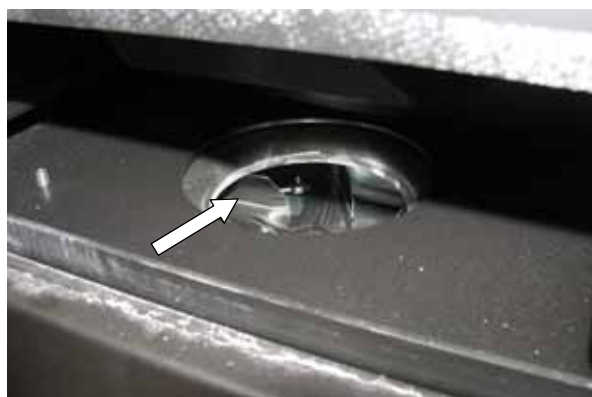
Fig. 48 : soufflerie des gaz de fumée
