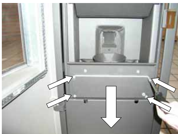
Fig. 138 : démontage du couvercle de révision
