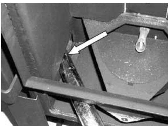
Fig. 142 : nettoyage des tirages de gaz de combustion inférieurs
