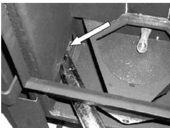
Fig. 75 : nettoyage du tirage de gaz de combustion inférieur
