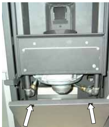
Fig. 173 : démontage du tablier d'habillage
