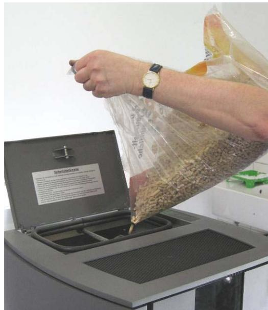
Fig. 63 : remplissage avec des pellets
