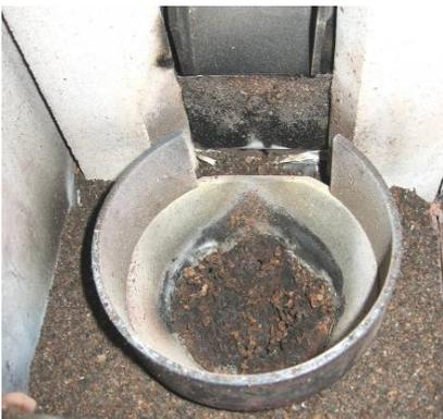
Fig. 70 : cendre dans la chambre de combustion
