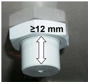
Fig. 63 : profondeur d'installation capteur de niveau
