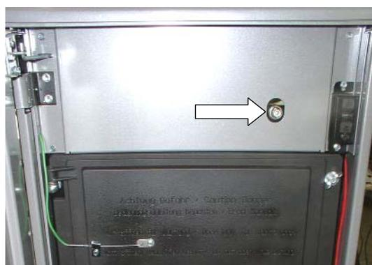
Fig. 44 : position de la soupape de purge d'air
