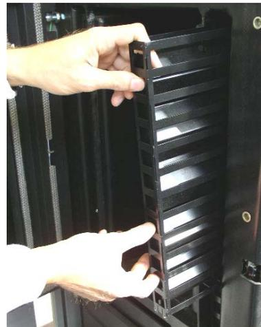
Fig. 134 : retrait de l'épuration de l'échangeur thermique
