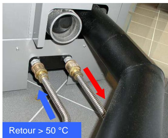
Fig. 42 : raccords hydrauliques BM 01
