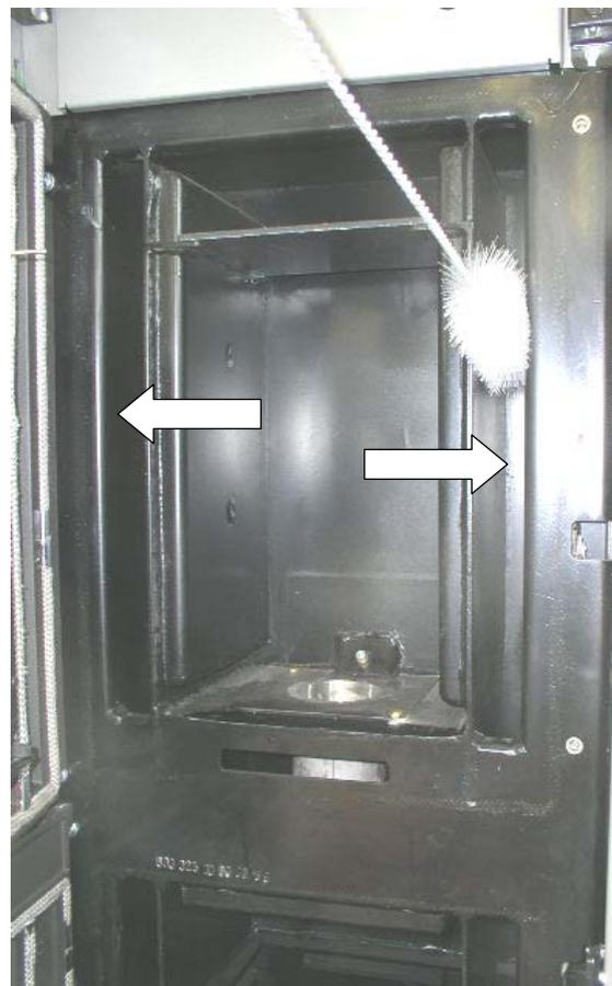
Fig. 135 : nettoyage des tirages de gaz de combustion haut
