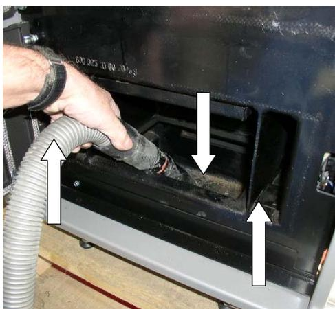
**Fig. 137 : aspiration de l'accumulateur des gaz de combustion et des tirages des gaz de combustion**
