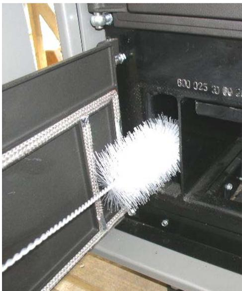
**Fig. 136 : nettoyage des tirages de gaz de combustion bas**
