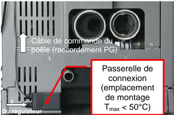
Fig. 54 : lieu de montage de la passerelle de connexion
