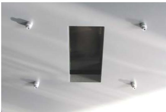
Fig. 37 : boulons de retenue vissés
