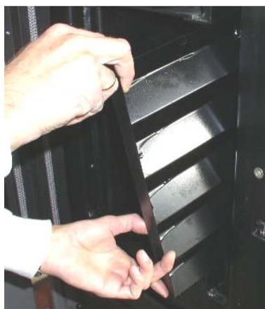
Fig. 133 : retrait du turbulateur
