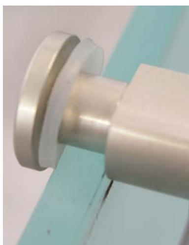
Fig. 33 : détail rondelle en silicone
