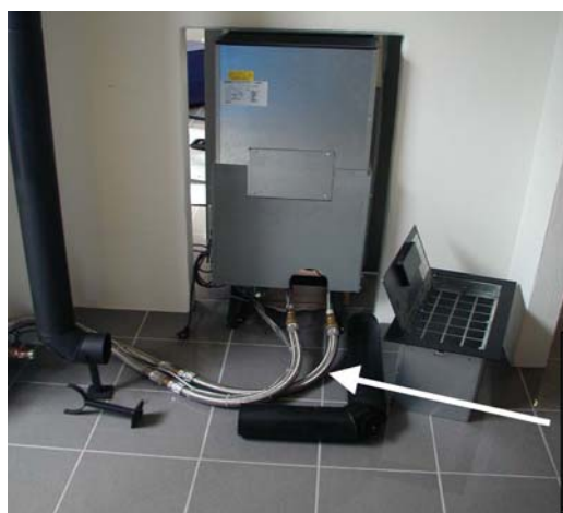
Raccordement du départ et retour avec des tuyaux flexibles (tube en acier inoxydable étanche au gaz - voir le programme des accessoires)
